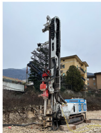
REALIZZAZIONE DELLE SONDE
