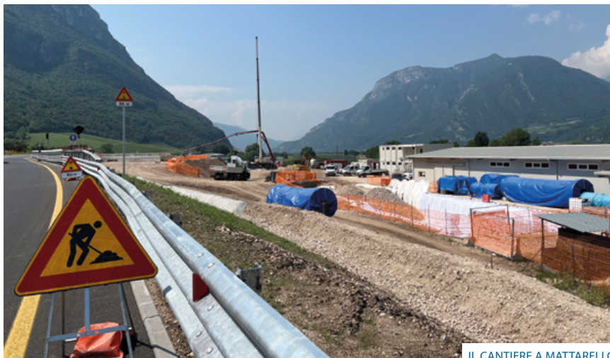
IL CANTIERE A MATTARELLO
